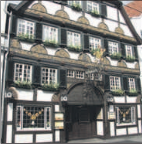
An der Gaststätte „Goldener Hahn“ wurden im vergangenen Jahr die Malerarbeiten aus dem Förderprogramm bezuschusst.
